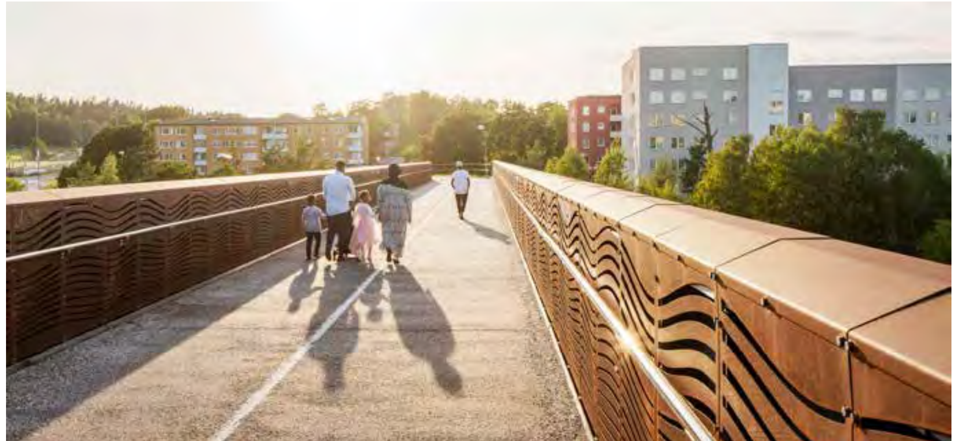
Gång- och cykelbro över Ulvsundavägen som kopplar samman Rinkeby med Ursvik.
