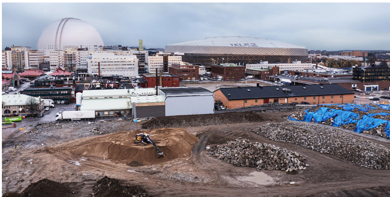
En eldriven grävmaskin från Volvo används i Slakthusområdet.
