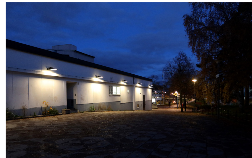
Stolparmaturer behöver lagas och kompletteras för att skapa jämnare belysning på de ytor man går på..
