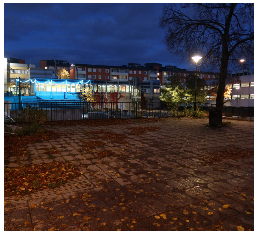
Östra entrén har bristfällig belysning.
