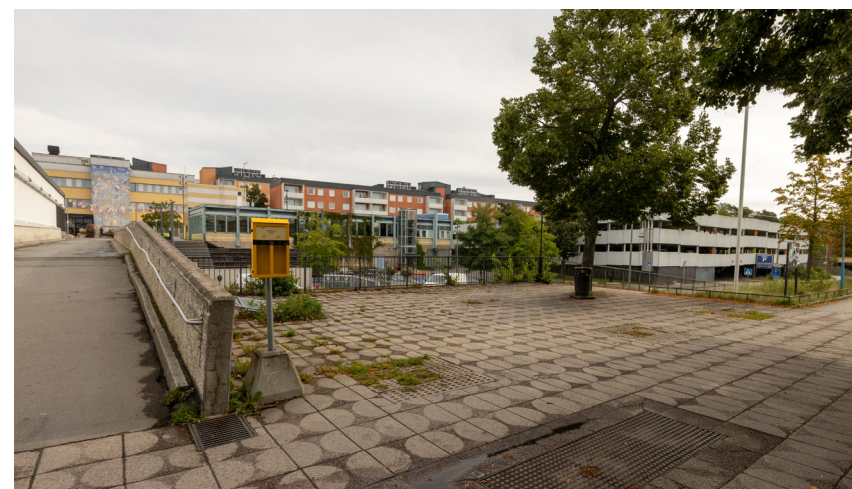
Den östra entrén.
