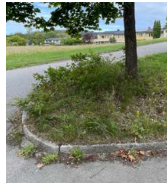
Busk- och trädplantering med granitkantstöd intill gångtunneln. Ogräs i asfaltsyta och yvig plantering signalerar att underhållet är lågt.
