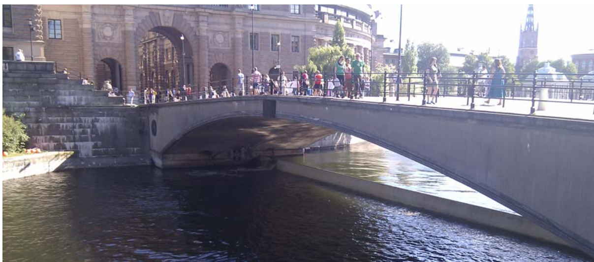
Riksbron med uppfälld lucka och tappning via fiskluckan. Foto: Johan Andreasson, augusti 2011.
