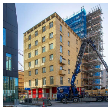
Stockholms första stora flerbostadshus i massivträ under uppförande. Hagastaden.
