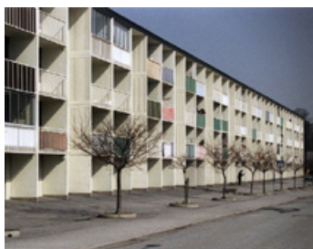
Balkonger mellan bärande betongskärmar. Markisväv ger variation. Gulddragargränd , fotograf Ingrid Johansson, Stockholmskällan
