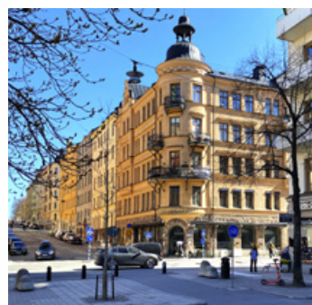
Smidesbalkonger som markerar byggnadens hörn, Schelegatan/Bergsgatan.
