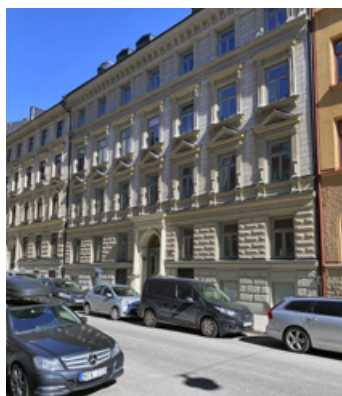
1880-talsfasad utan balkonger, Pipersgatan.
