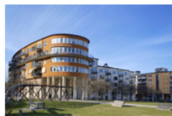
Balkong som löper runt byggnaden med inspiration från funktionalismen, Löjtnantsgatan .
