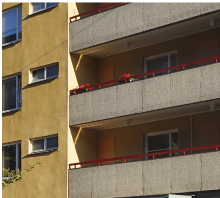
Loftgångarna av betong har renoverats och fått röda räckena, Hornsgatan .
