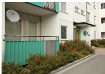
Balkongräcke i korrugerad plåt med överliggare i aluminium, Tensta, fotograf Ingrid Johansson, Stockholmskällan.
