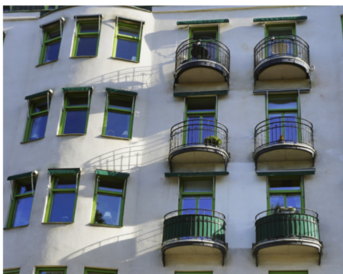
De två översta balkongerna är ett senare tillägg och passar väl in i fasadens uppbyggnad, Hantverkargatan .
