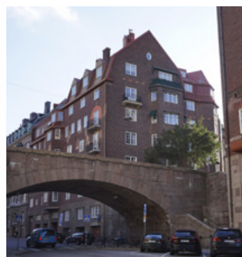
En nationalromantisk byggnad försedd med ett fåtal balkonger med smidesräcken, Runebergsgatan.
