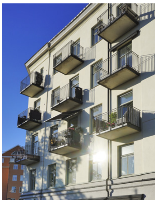
Nya balkonger mot gata, Hornstulls strand .
