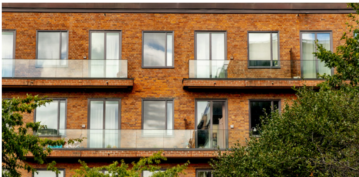
Nytt tillägg av grunda längsgående balkonger med glasträcke. Balkongplattans tegelkant harmonierar med fasaden, Eastmanvägen .
