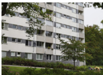
Helt indragna balkonger med täta fronter av betong, Bredängs allé .
