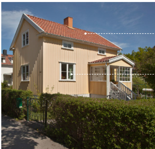
Enkelt sadeltak med en sammanhållen takyta, täckt av rött lertegel.
