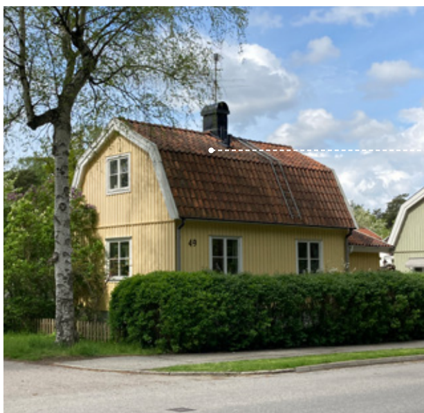
Brutet sadeltak, så kallat mansardtak.
